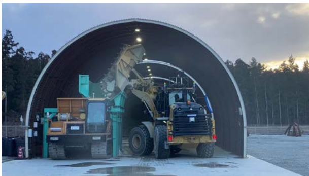
現場トンネル
